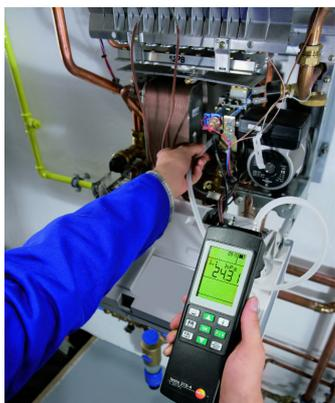
Kontrola připojovacího a provozního tlaku plynu
